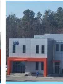
LIG 정밀기술 2층 증축 및 옹벽공사
