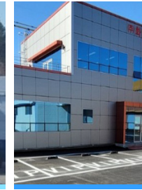
(주)화인 사무동 및 식당 증축공사
