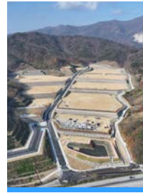
신규부지 조성 토목 및 우,오수공사
